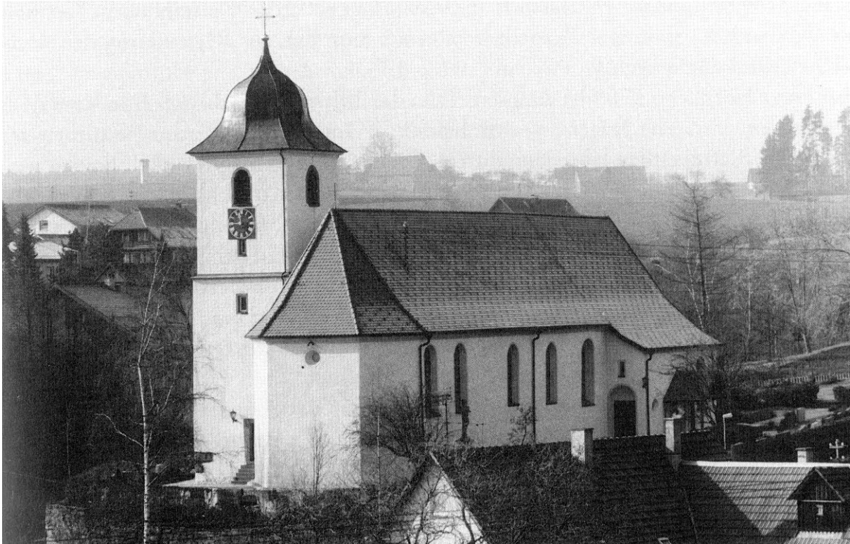
Abb. 38: Die Fischbacher Pfarrkirche St. Mauritius, Ansicht von Nordosten (Photo Jakobs)
